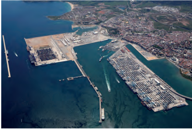
Vista aérea del puerto de Algeciras
