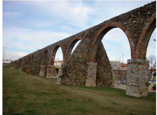
Tramo del acueducto en la barriada de El Cobre
