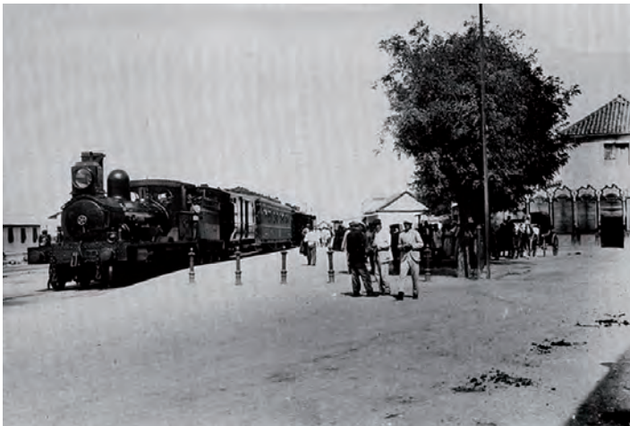
Antigua estación de ferrocarril, Algeciras
